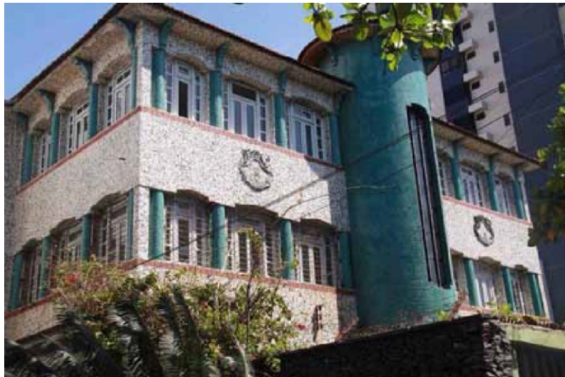
Figura 45 Edifício Caiçara. Fonte: (Nóbrega and Andrade)
