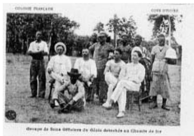
Fig. 4.11 Colonie Française – Côte d'Ivoire – Groupe de Sous Officiers du Génie détachés au Chemin de Fer 24
