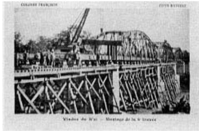
Fig. 4.4 Colonie Française – Côte d'Ivoire – Viaduc de N'zi – Montage de la 6 e travée 16
