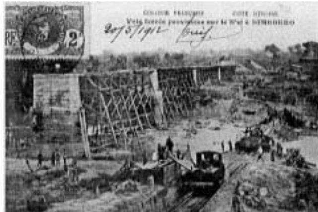
Fig. 4.1 Colonie Française – Côte d’Ivoire – Voie ferrée provisoire sur le N’zi à Dimbokro 13
