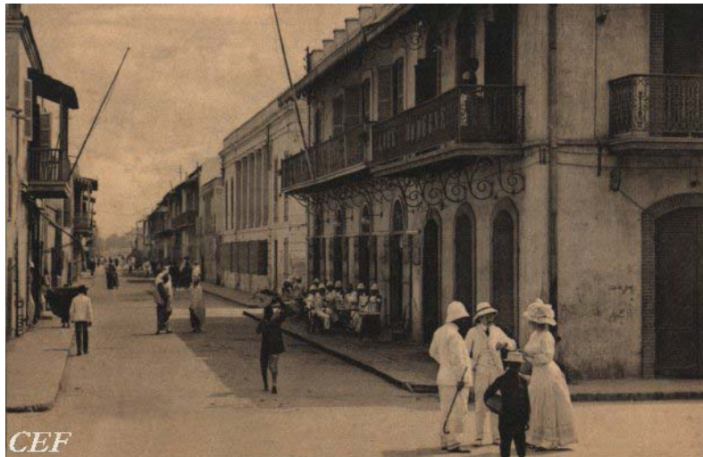
Fig. 4.12 Rue Lebon (sud) 25
