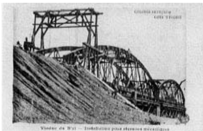
Fig. 4.6 Colonie Française – Côte d'Ivoire – Viaduc de N'zi – Installation pour riveuses mécaniques 18
